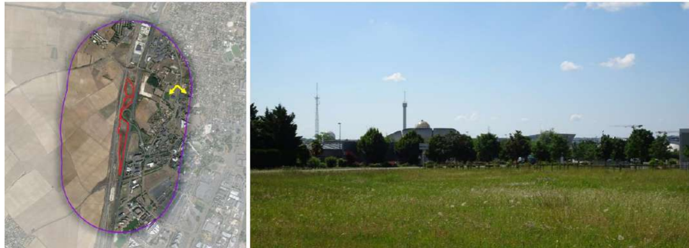
Figure 171 : Photographie du relief plat servant de socle aux infrastructures du Futuroscope et de son technopôle (Crédit photo : NCA Environnement)
