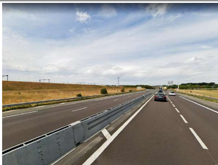
Photographie de l'état initial
