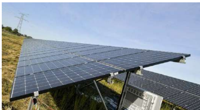
Figure 3 – Modules photovoltaïques (hauteur 2,18m par rapport au sol)
