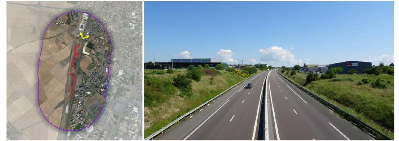
Figure 181 : Photographie de l'Autoroute 10 en direction du nord (Crédit photo : NCA Environnement)
