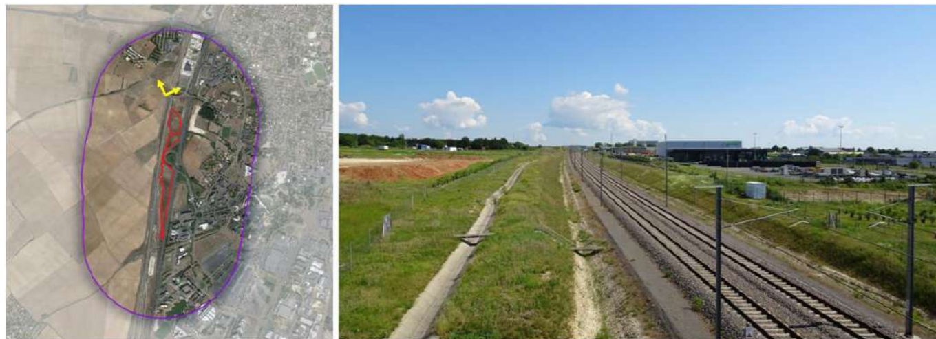
Figure 180 : Photographie de la LGV Sud Europe Atlantique en direction du nord (Crédit photo : NCA Environnement)
