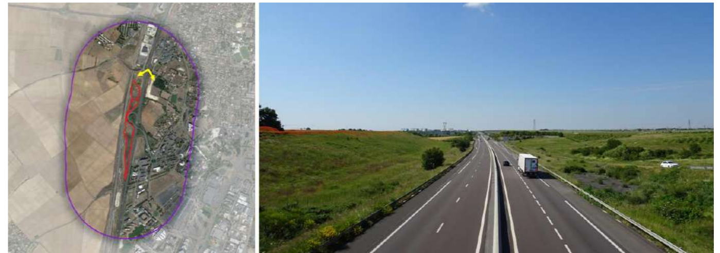
Figure 178 : Photographie de l'A10 connectant Bordeaux à Paris (Crédit photo : NCA Environnement)
