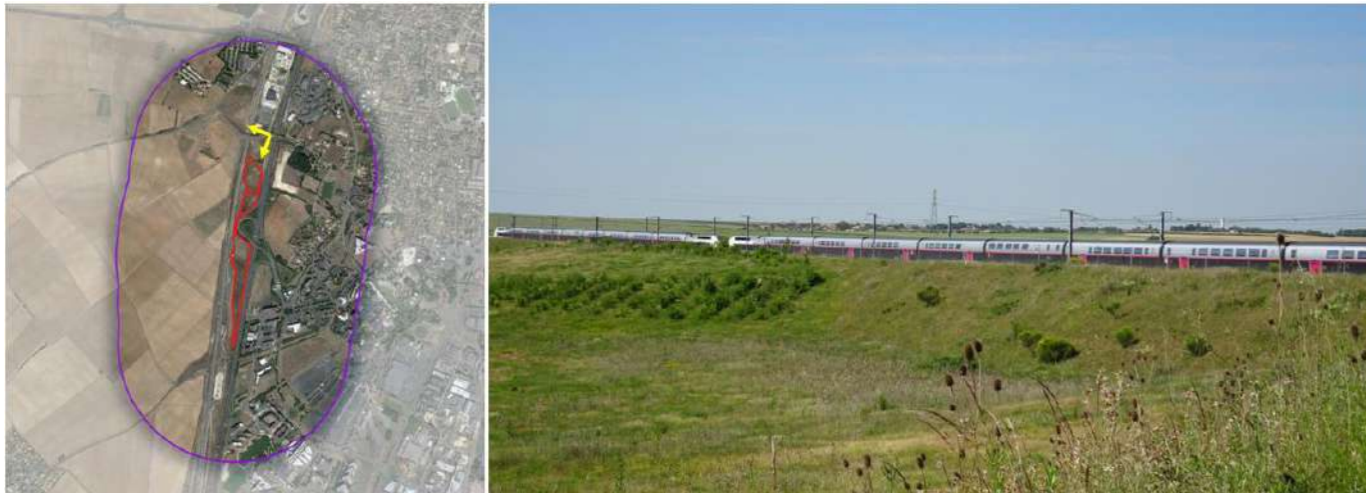
Figure 176 : Photographie de la limite ouest présentant le talus de la LGV Sud Europe Atlantique faisant séparation avec les surfaces agricoles (Crédit photo : NCA Environnement)
