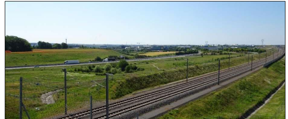
Figure 148 : Photographie présentant à la fois l'A10 ainsi que la LGV Sud Europe Atlantique (Crédit photo : NCA Environnement)
